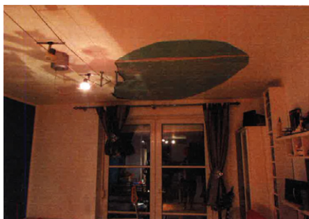
19 + 20 Spontaner Deckenputzabsturz zirka 20 Jahre nach Erstherstellung.
